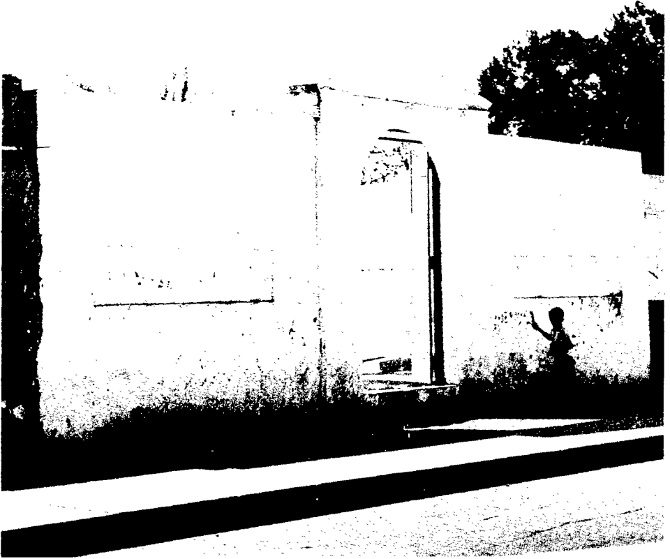
Fachada del Cementerio Judío de Barcelona.
