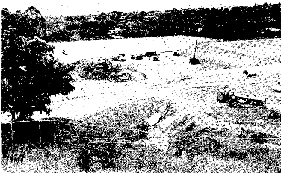
Una vista panorámica de los trabajos de construcción del centro social deportivo "Hebraica".
